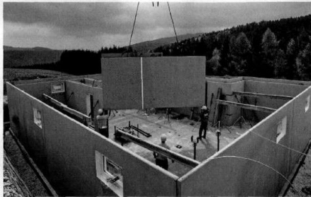
Ein Fertiggeller wird wetterunabhängig produziert, steht schon nach wenigen Tagen und bietet neben erhöhter Wohnqualität auch effiziente Energieersparnis.
